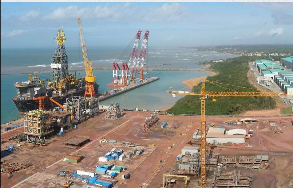
Visão Geral Estaleiro – Presente - Jun-2016
