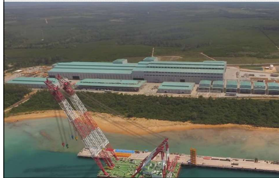
Galpão de Processamento de Aço - Abr-2016
